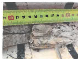
S14 : Détail du sondage, H3
