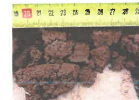
S01 : Détail du sondage, H1
