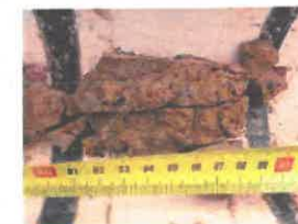
S17 : Détail du sondage, H3
